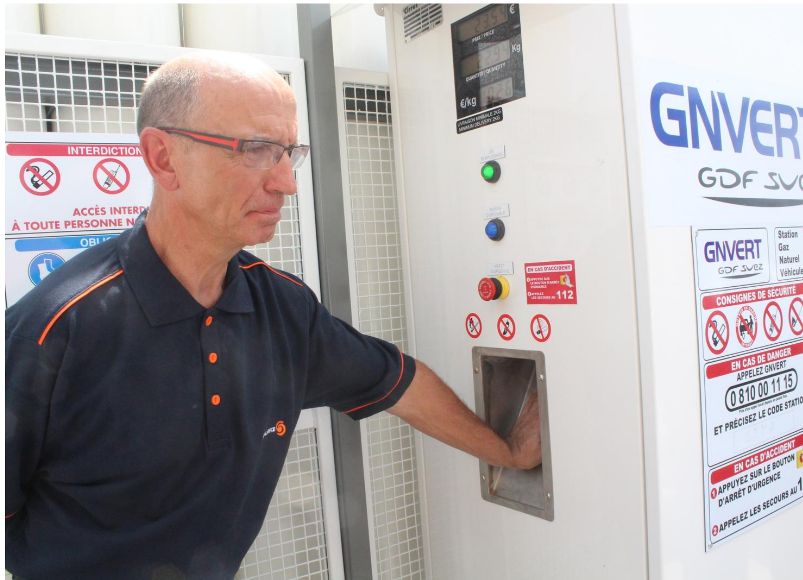
En juillet était lancée la première station GNV temporaire. La définitive est en cours de construction aux Jourdiés.
