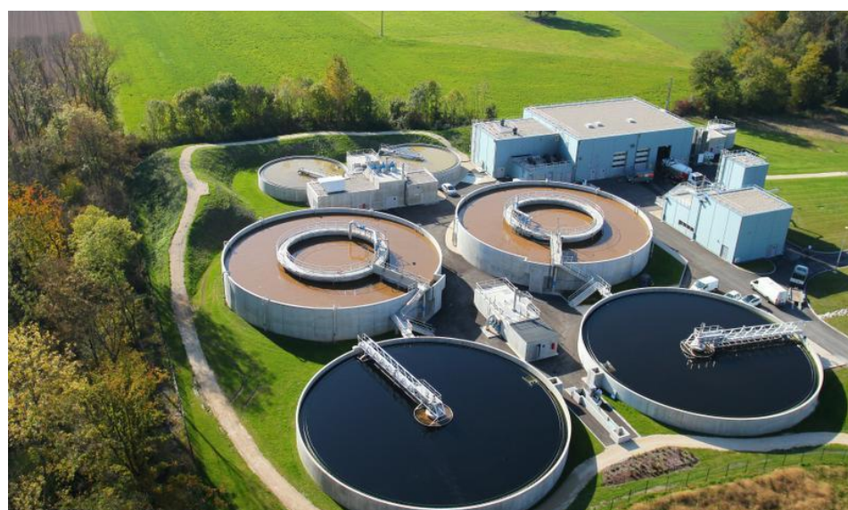
La station d'épuration produira du biométhane en carburant ou le réinjectera dans le réseau.
